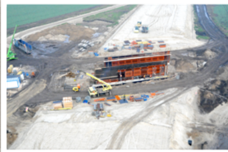
Monitoring postępu prac budowy obwodnicy Inowrocławia
